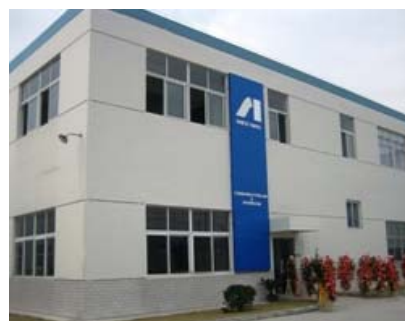
上海コミュニケーションラボ&ショールーム
