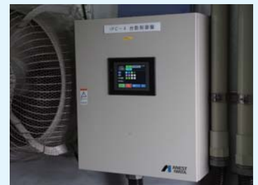
FRL-370×2台をベースロード機にし、FRV-370（インバータ機）で容量制御。運転コントロールは台数制御盤「IPC-4」で最適運転されている。最終バックアップはSLP-300Eで行っている。
