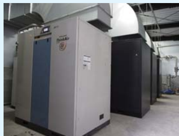
FRL-370×2台をベースロード機にし、FRV-370（インバータ機）で容量制御。運転コントロールは台数制御盤「IPC-4」で最適運転されている。最終バックアップはSLP-300Eで行っている。
