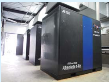
FRL-370×2台をベースロード機にし、FRV-370（インバータ機）で容量制御。運転コントロールは台数制御盤「IPC-4」で最適運転されている。最終バックアップはSLP-300Eで行っている。
