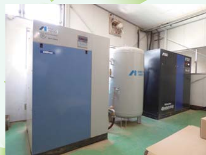
オイルフリースクロールコンプレッサと クローオイルフリーコンプレッサ の2台で工場全体のエアをカバー
