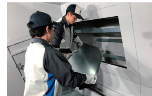
エリミネータ着脱はボルトレスの為、容易に行えます。
